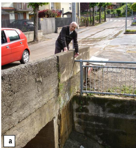
Foto 10: Ponte di via Cattaneo con indicazione del livello raggiunto dall'acqua durante l'alluvione (a) e smottamenti delle sponde a valle del ponte (b).
