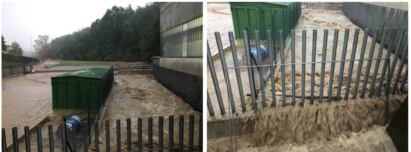
Foto 7 Officine della Gavarnia: tracimazione immediatamente a monte del tratto tombinato (manufatto GV12)
