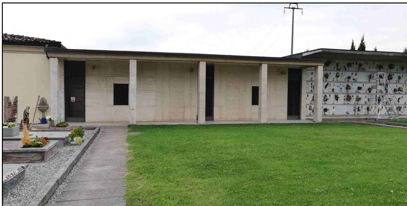
F.06 – Vista Locali Custode, Bagni e Sala Mortuaria
