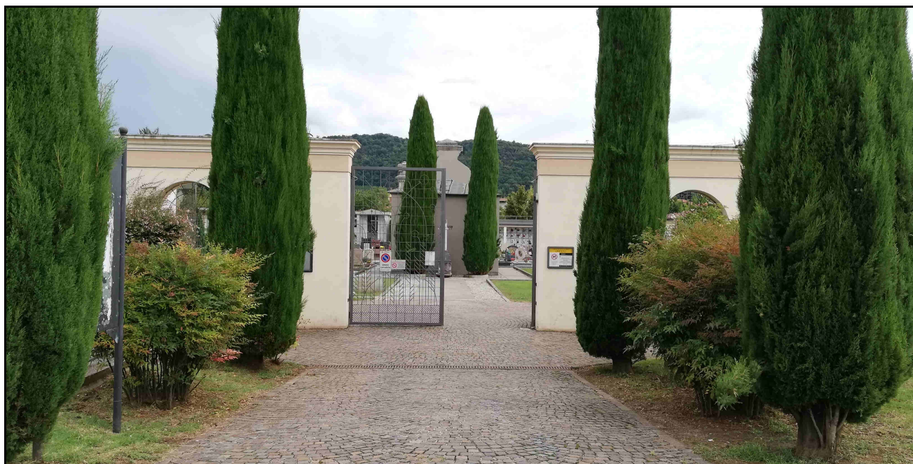
F. 02 – Vista Ingresso Secondario dall'esterno
